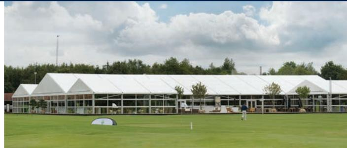
Gebäude verfügt standardmäßig über den Neptunus Systemboden und eine integrierte Dachentwässerung. Das Innere der Alure präsentiert sich dank der stilvollen modernen horizontalen PVC- oder Glaspaneele sauber und glatt. Glas- und Wandpaneele können kombiniert werden. Das Dach ist Standardmäßig opak (lichtundurchlässig). Dank der speziellen Dachentwässerung bleibt das Dach immer straff und das Regenwasser wird an zentralen Punkten abgeleitet.
